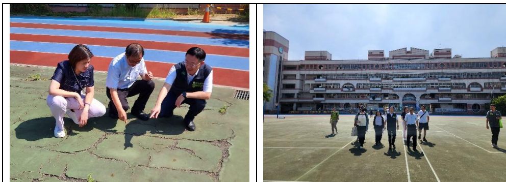
(三)114 運動場整修工程
