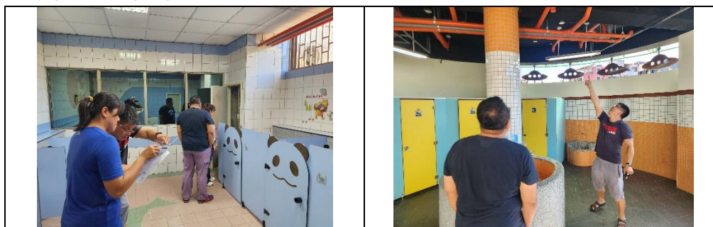
(四)補辦廁所管道間管線漏水修繕採購
